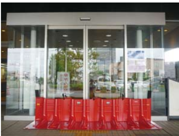
↑正面玄関の止水板設置訓練
